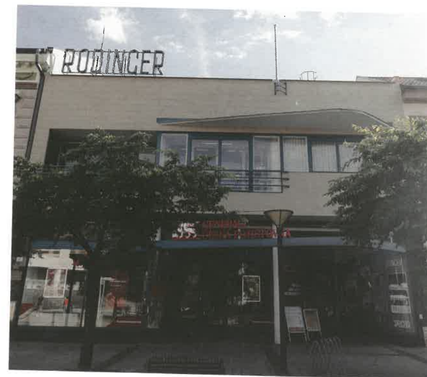
Rodingerova vila, nejhezčí z domů na Dolním náměstí.
