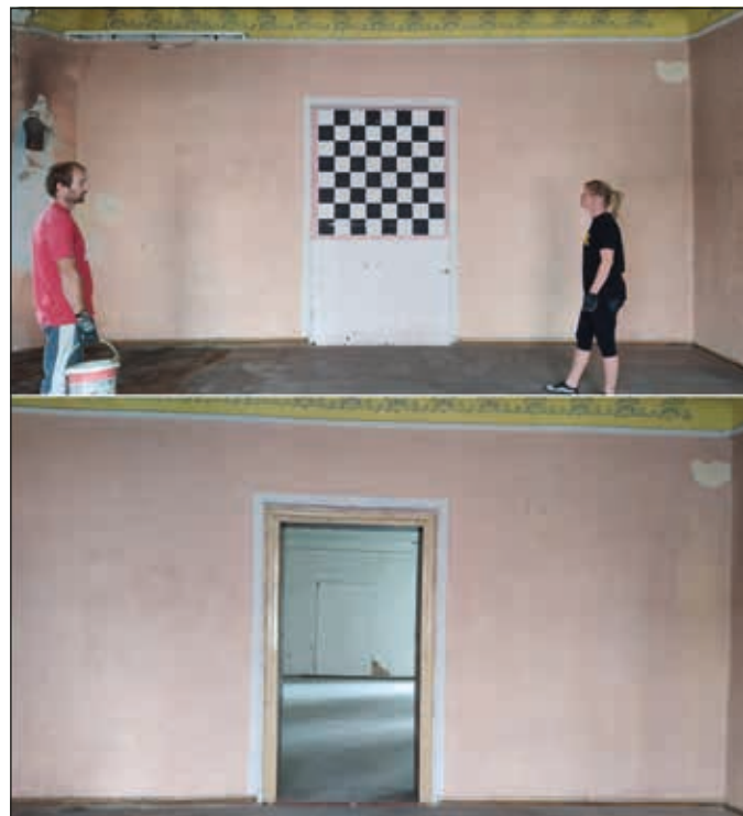
Krajní místnost - obnovení průchodů
