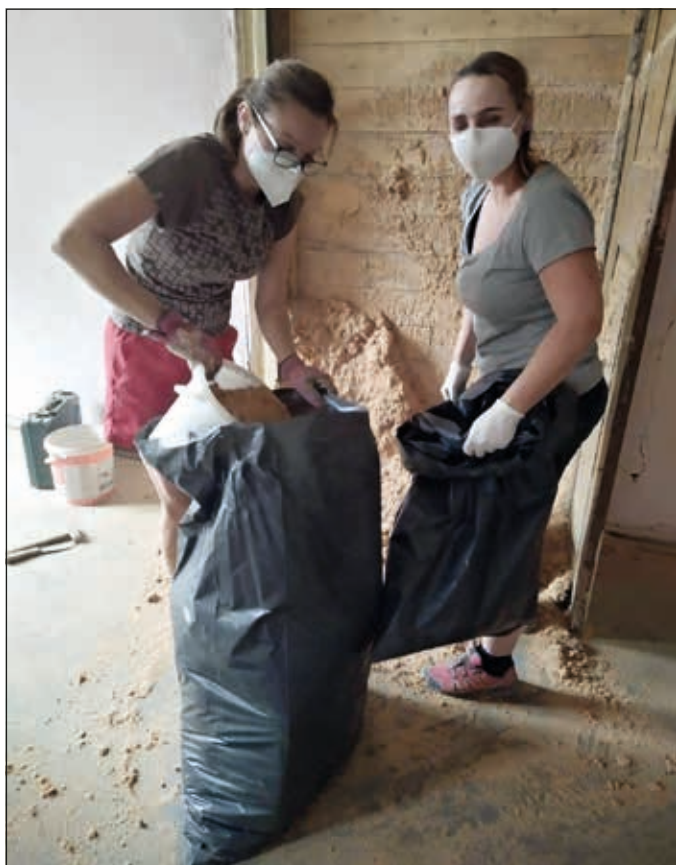
Hlavní sál, obnovení průchodů
