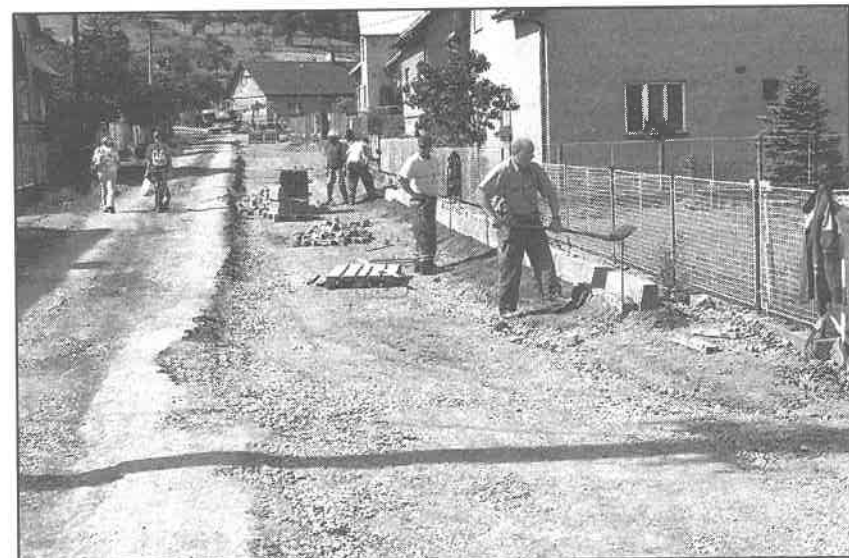
Ze silnice v hořansku je teď jedno velké staveniště.
