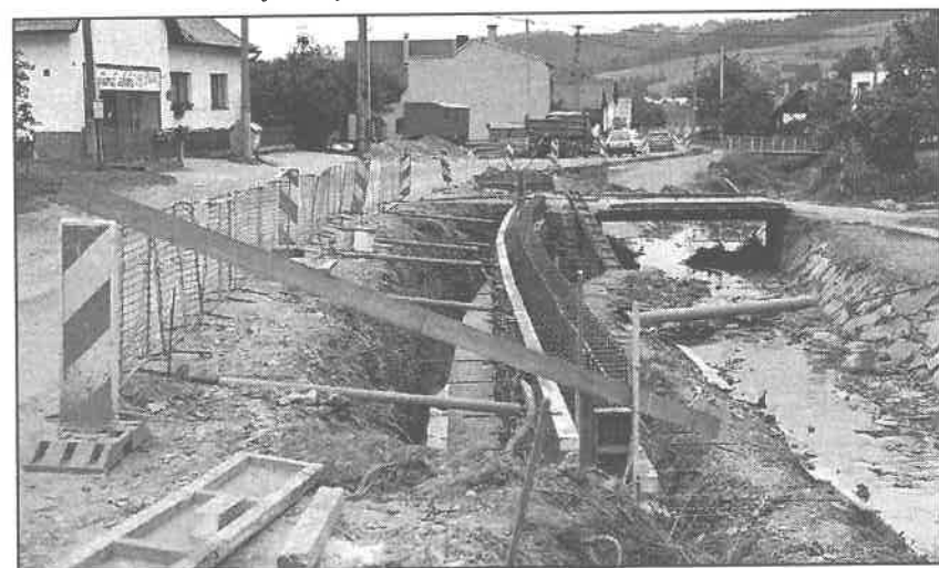
Budování opěrné zdi u obchodu u Daňů.
